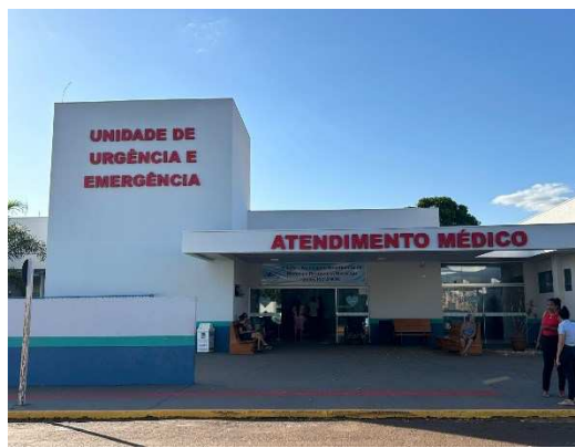
Foto: Após a pintura
