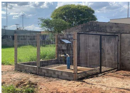
Foto: Poço artesiano instalado
