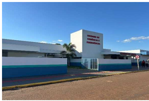
Foto: Após a pintura
