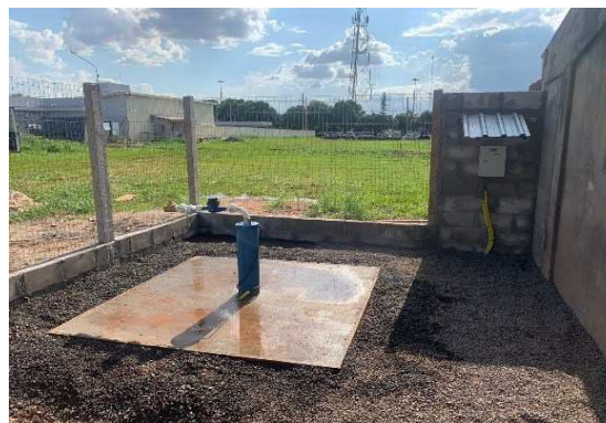
Foto: Poço artesiano instalado
