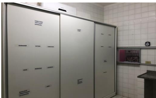
Novo armário para armazenamento de materiais
