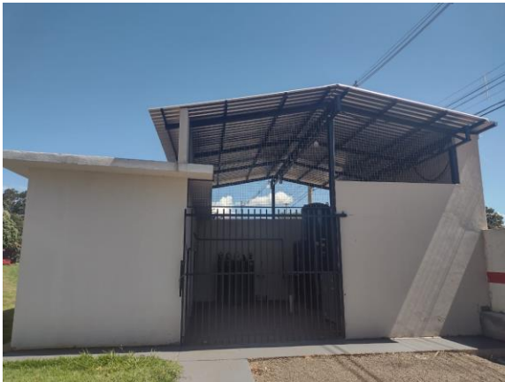
Abrigo da Usina de Oxigênio
